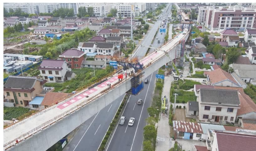
8月24日上午,随着最后一方混凝土浇筑入槽,南通港疏港铁路一期工程最后一联连续梁——跨宁启铁路特大桥(76+128+76)m连续梁顺利实现合龙,标志着项目全线所有连续梁施工全部顺利收官,为后续跨宁启铁路特大桥段有砟轨道铺轨创造了有利条件。
